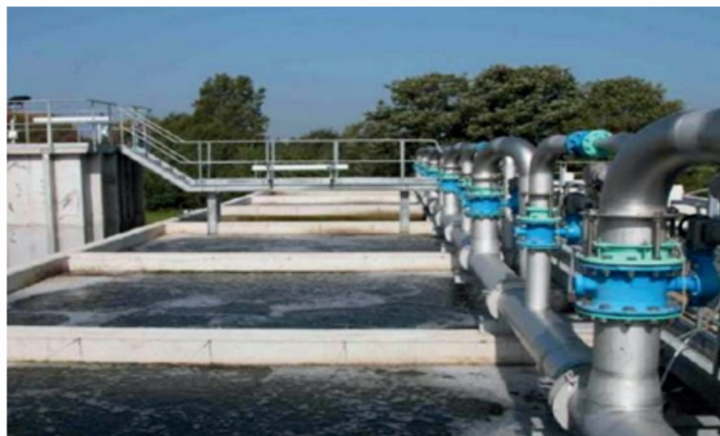
THI CÔNG ĐƯỜNG CẤP THOÁT NƯỚC NỘI BỘ
