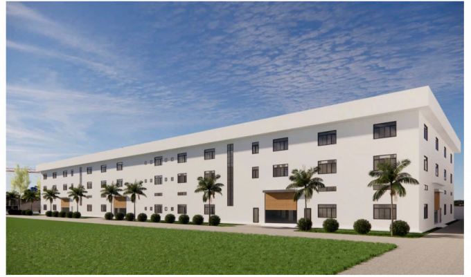
NHÀ XƯỞNG SỐ 2 – KCN BÀU BÀNG
