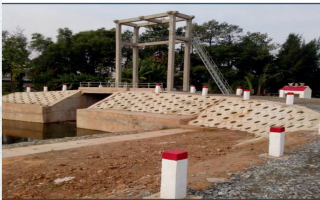
XÂY DỰNG CỐNG NGẮN TRIỀU TẠI RẠCH CẦU ĐÚC NHỎ, QUẬN THỦ ĐỨC
