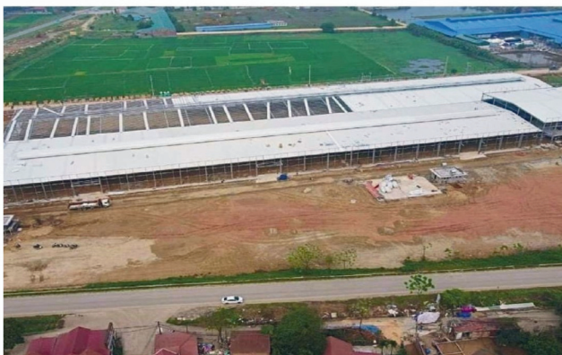
NHÀ MÁY SẢN XUẤT THIẾT BỊ XÂY DỰNG VIỆT ĐỨC
