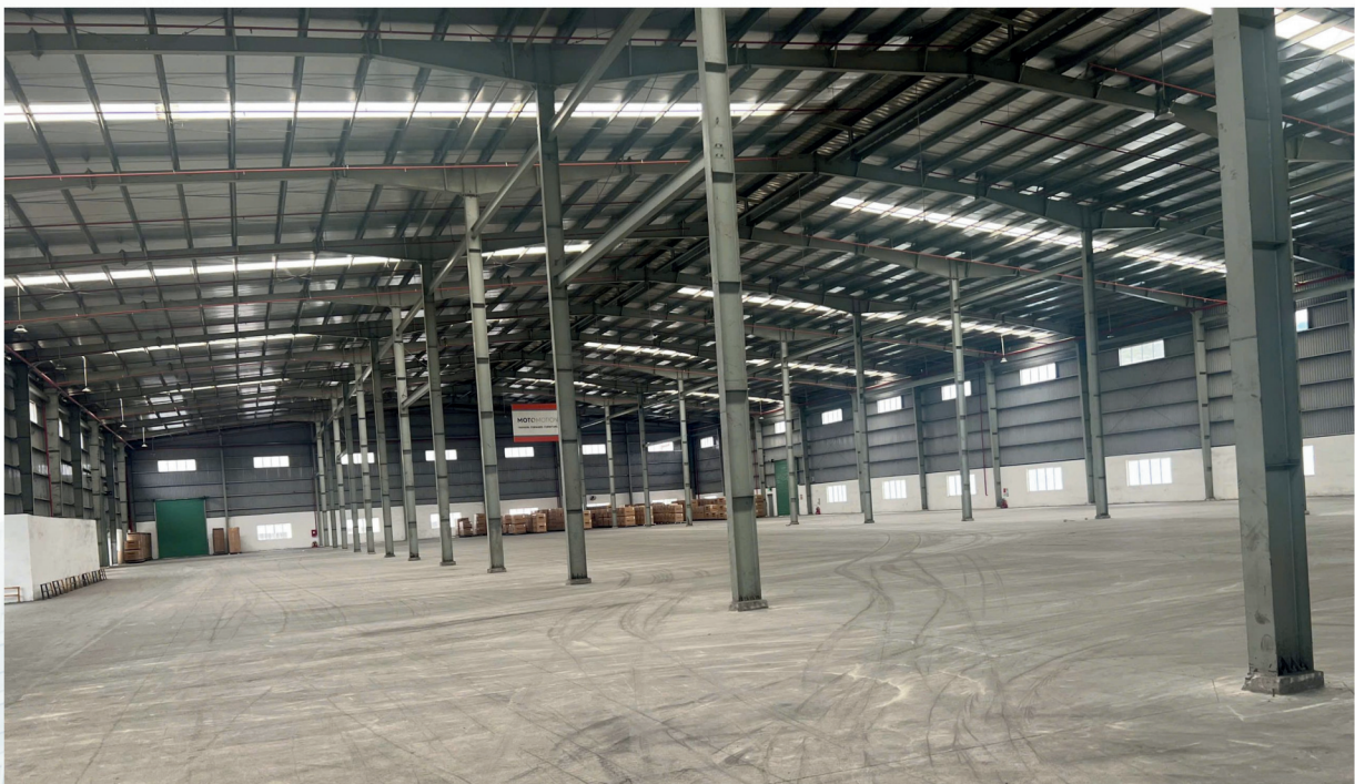
NHÀ XƯỞNG SỐ 7 – MỸ PHƯỚC 3
