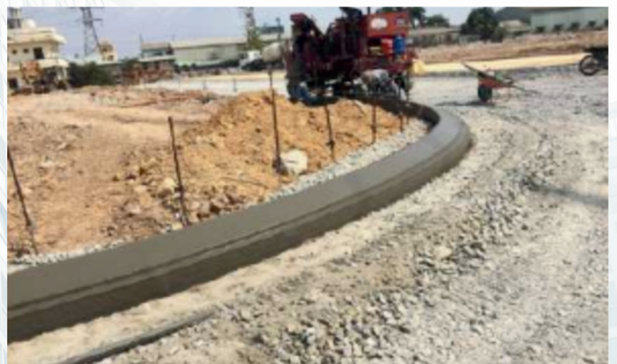
THI CÔNG BÓ VỈA
