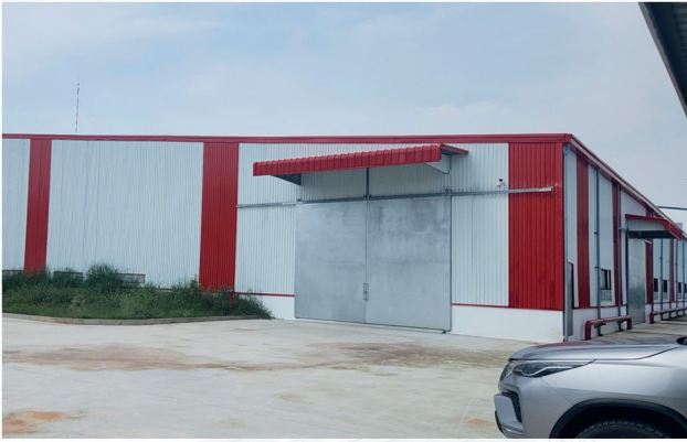
NHÀ XƯỞNG SỐ 1 – KCN BÀU BÀNG
