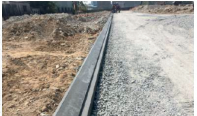
THI CÔNG BÓ VỈA
