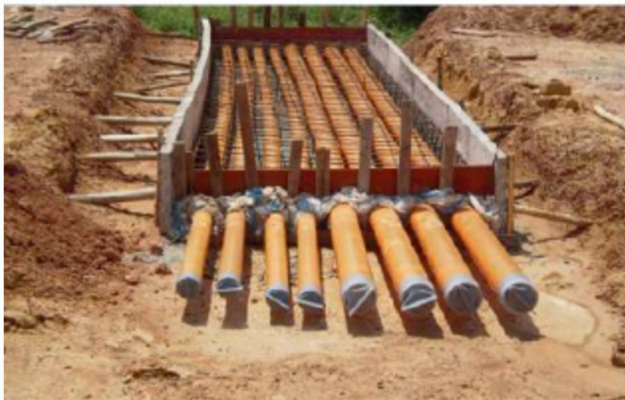
LẮP ĐẶT ỐNG ĐIỆN BĂNG ĐƯỜNG
