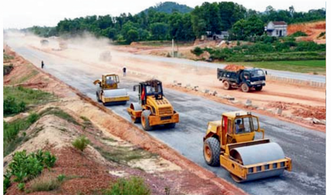
THI CÔNG ĐƯỜNG GIAO THÔNG
