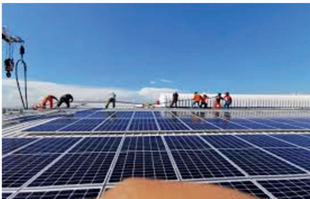
THI CÔNG LẮP ĐẶT PIN NĂNG LƯỢNG MẶT TRỜI
